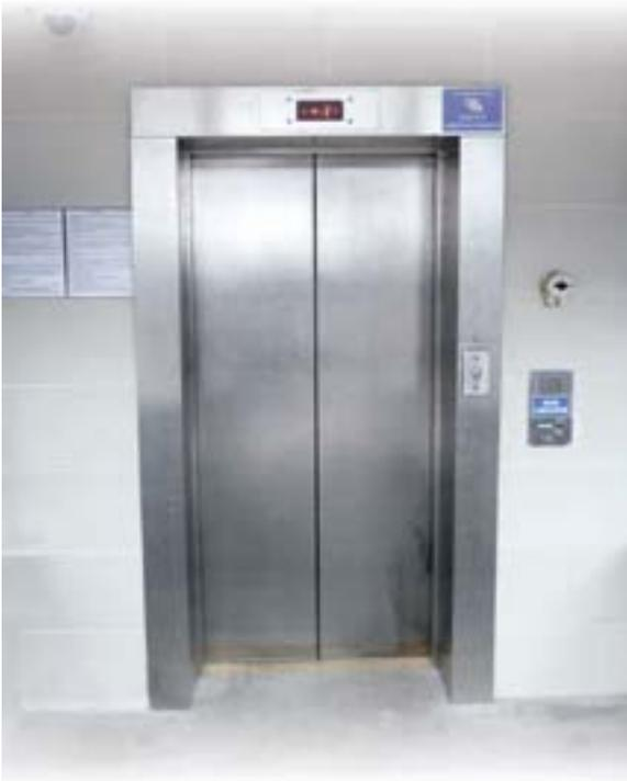
Выпускаются лифты для перевозки пожарных подразделений. Они имеют противопожарные двери шахты, а также в потолке кабины люк.
